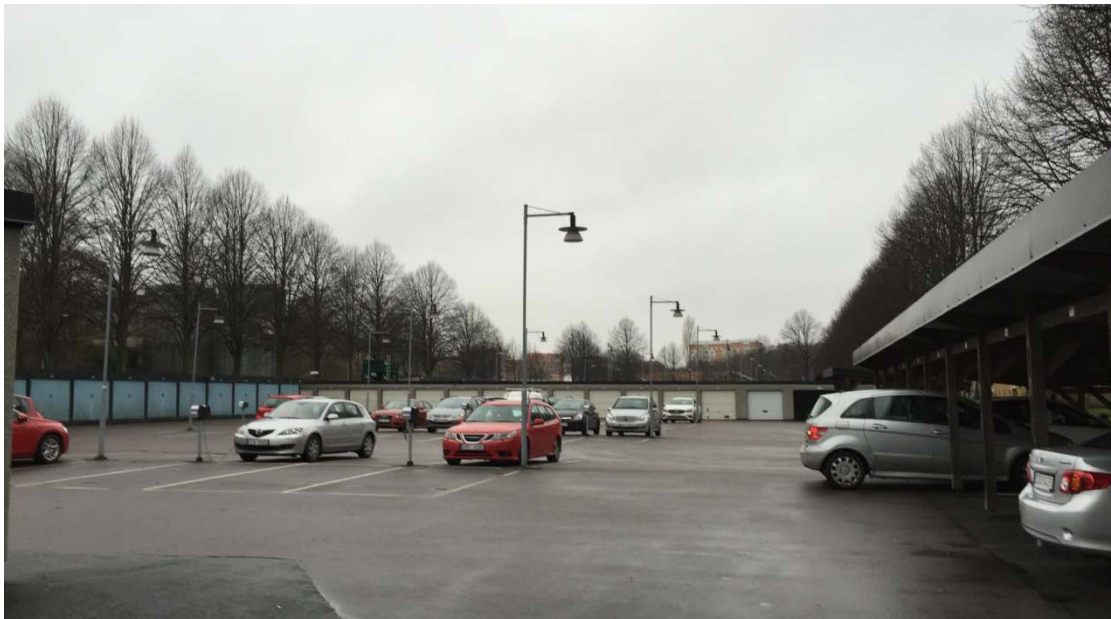
Befintlig bebyggelse; asfalterade parkeringsytor omgivna av garage och carportar.
